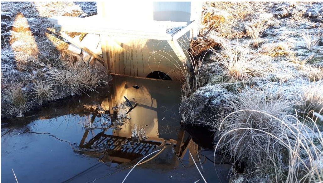
Kuva 5. Valmis säätopatorakenne. Veden korkeutta voi säädellä settilankuilla.
