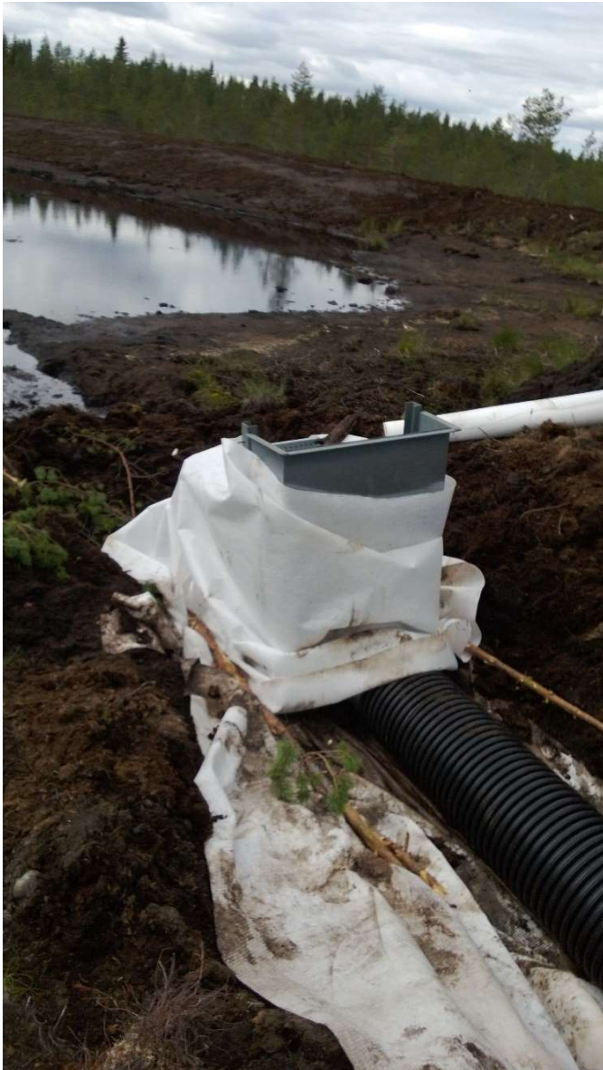
Kuva 5. Esimerkki säätöpadon asennuksesta.
